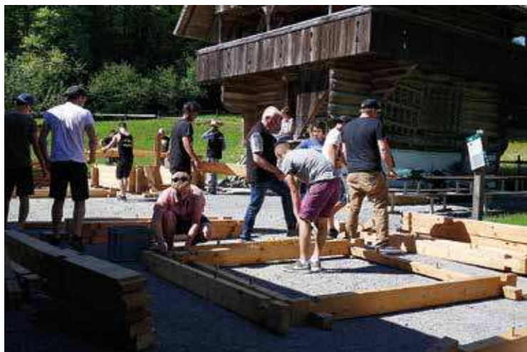
Der Blockhausbau beginnt
