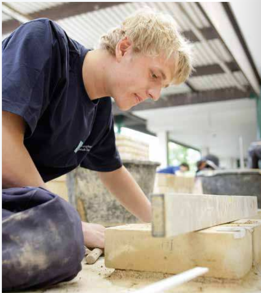
Präzises Arbeiten auf dem Bau
