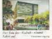
Der Bau des Kultur- und... Campus im Polyfeld...
